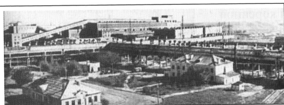
В феврале 1954 г. три секции Джезказганской обогатительной фабрики № 1 были сданы в эксплуатацию.
